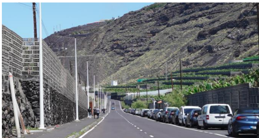
Tramo de la carretera LP-213 a su paso junto al límite oriental del sector.
