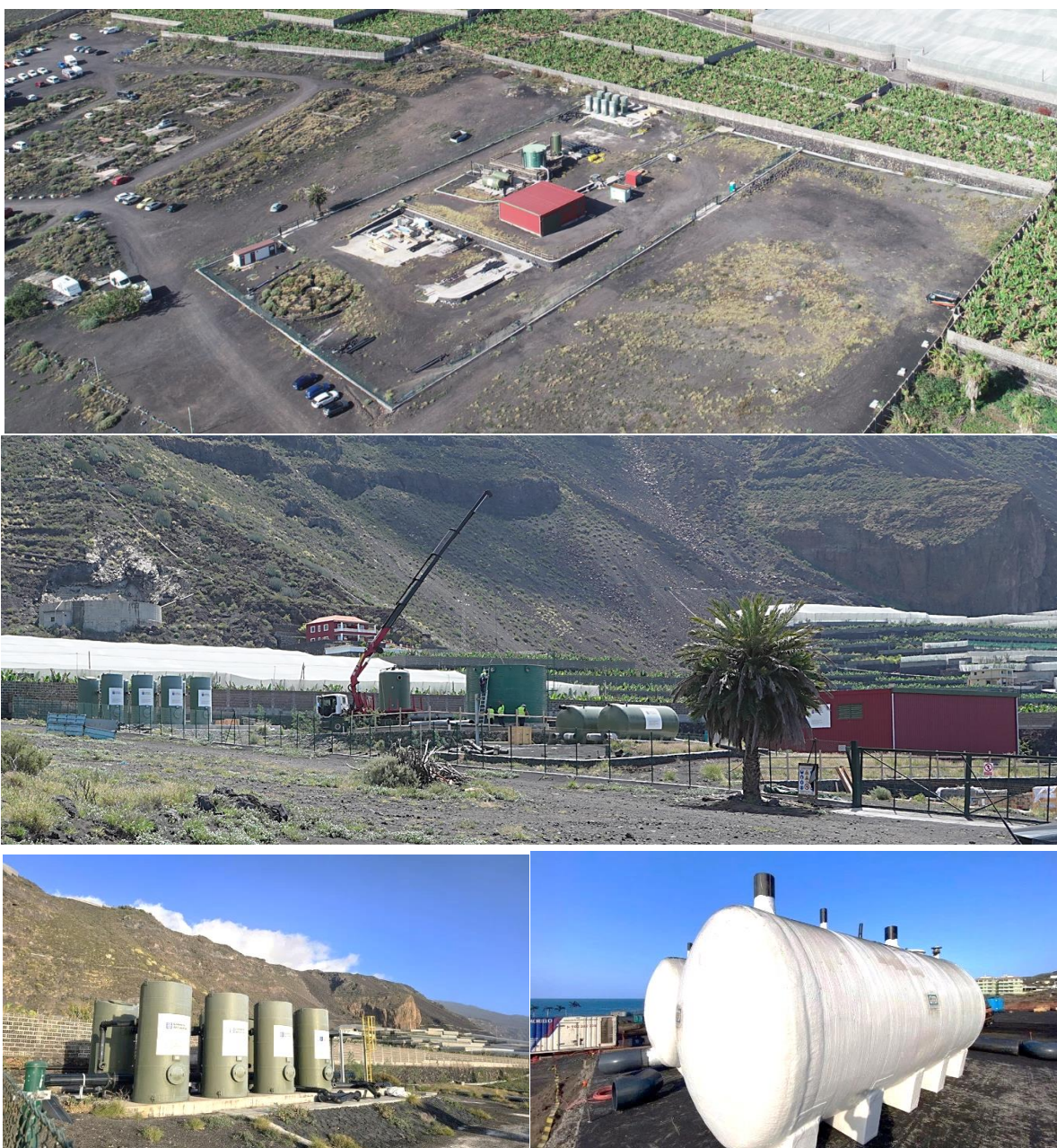
Estación desaladora temporal siendo desmantelada.
