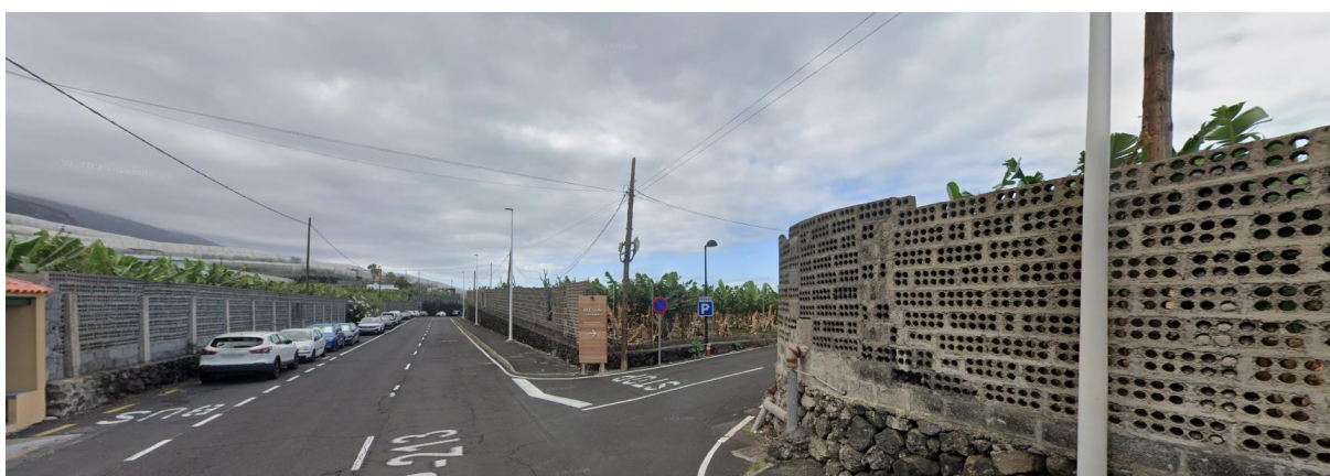
Redes de tendido telefónico vistas desde las áreas de contorno en el borde este del ámbito de estudio.
