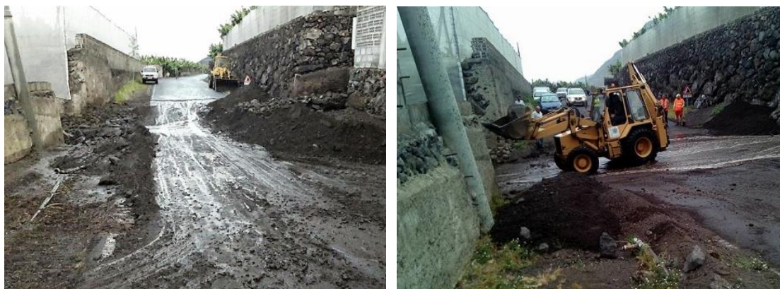
Inundaciones, en el entorno del ámbito, asociadas a los episodios de lluvias torrenciales de las fechas 05/11/2016 (izqda.) y 26/04/2017 (dcha.).
