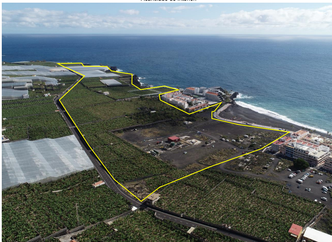
Vista general desde el norte. Se añade ámbito de IPST de manera aproximada.
