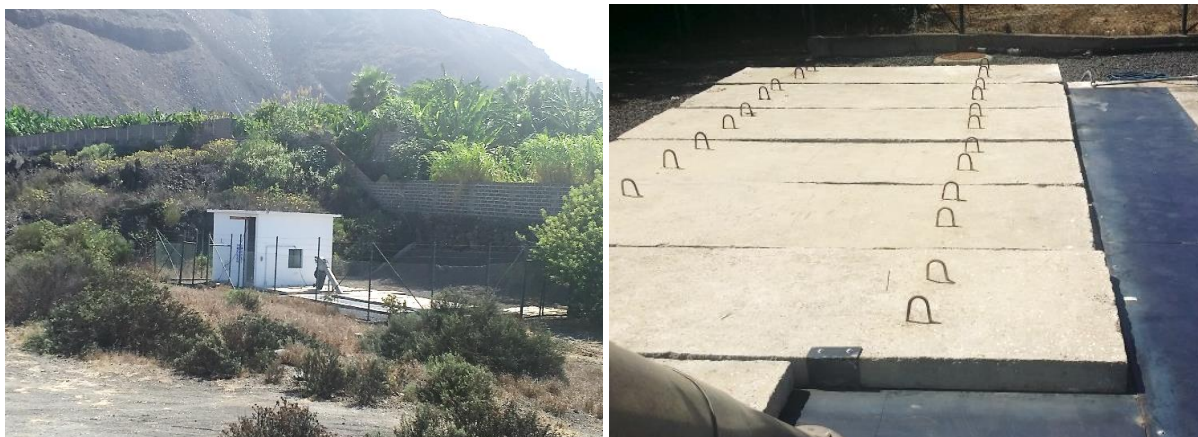
EBAR de Puerto Naos.
