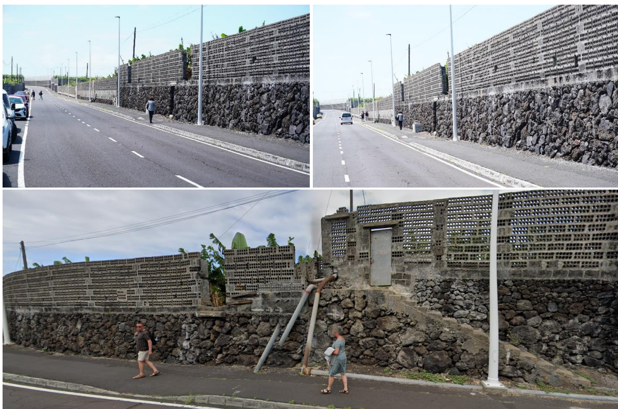
Muros de piedra seca modificados con bloques de hormigón y reforzados con cemento, junto a la carretera LP-213.
